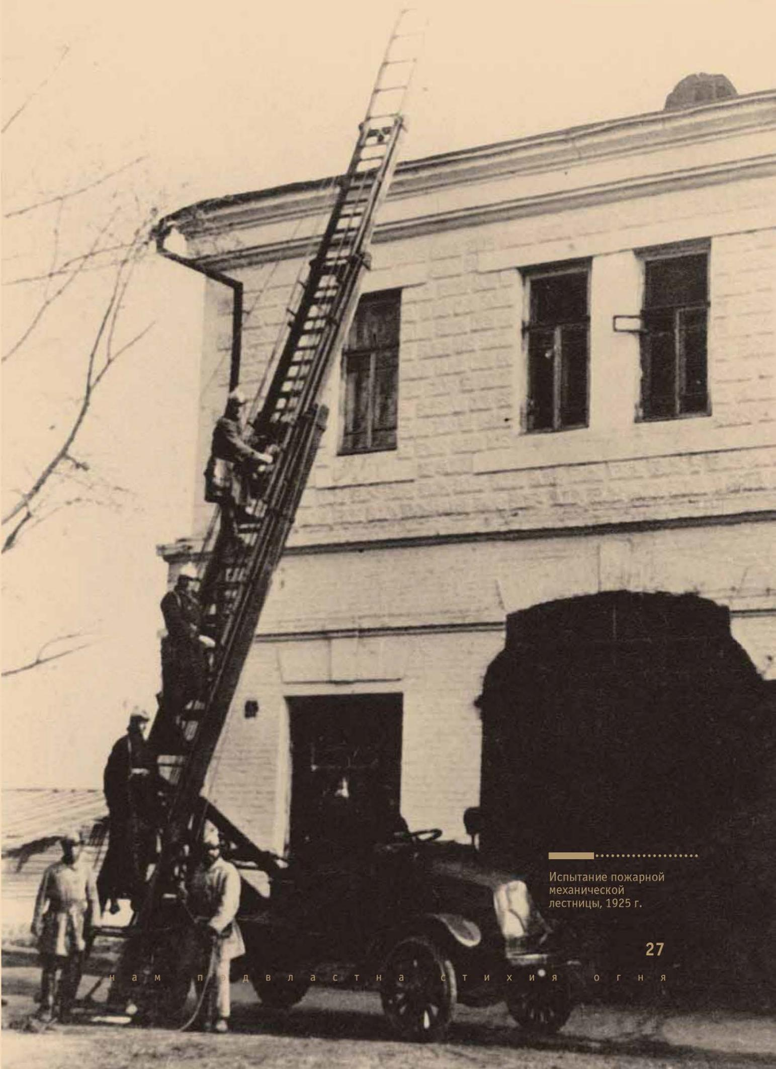
Испытание пожарной механической лестницы, 1925 г.
